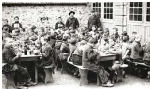
ÉPREUX. Cantine scolaire de l'École de la Madeleine.
