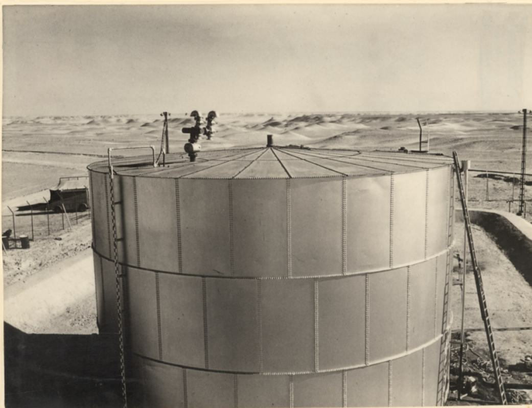
HASSI-MESSAOUD: Réservoirs au départ du petit pipe-line. ( Photo CFP A.POL )
