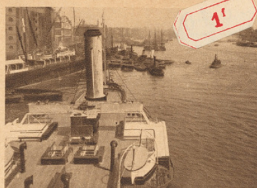
LONDRES : LA TAMISE ET LE NOUVEAU PONT
