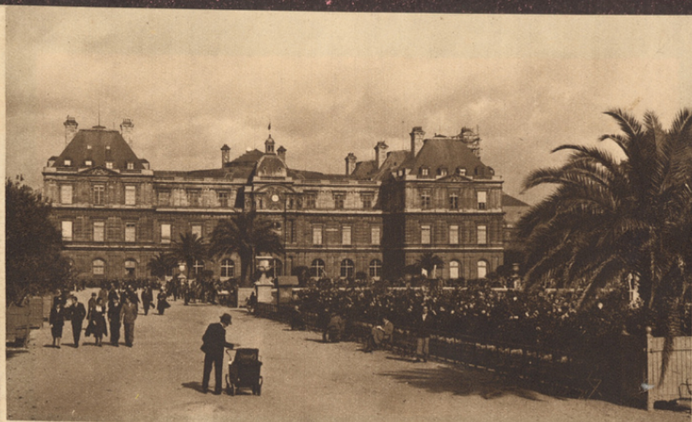
PALAIS DU LUXEMBOURG à Paris. — Ancien Palais Médicis, construit en 1615 pour Marie de Médicis par l'architecte Salomon de Brosse.
