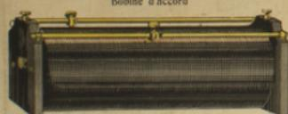
Le rôle de la bobine d'accord, appelée aussi bobine de self, est de pouvoir, suivant les besoins, allonger ou raccourcir l'antenne en déplaçant le long de la tige de cuivre le curseur pour prendre un plus ou moins grand nombre de tours de fil.
