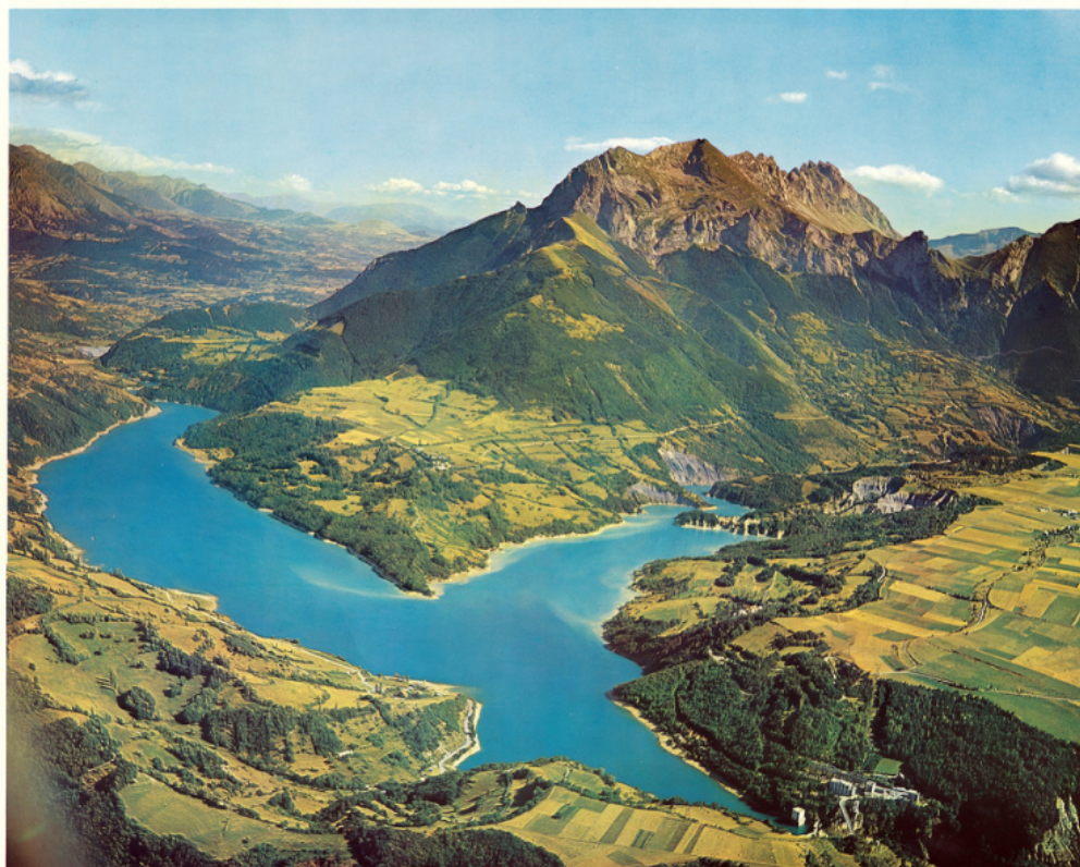
90. ALPES DU DAUPHINÉ — Lac du Sautet et le barrage.
