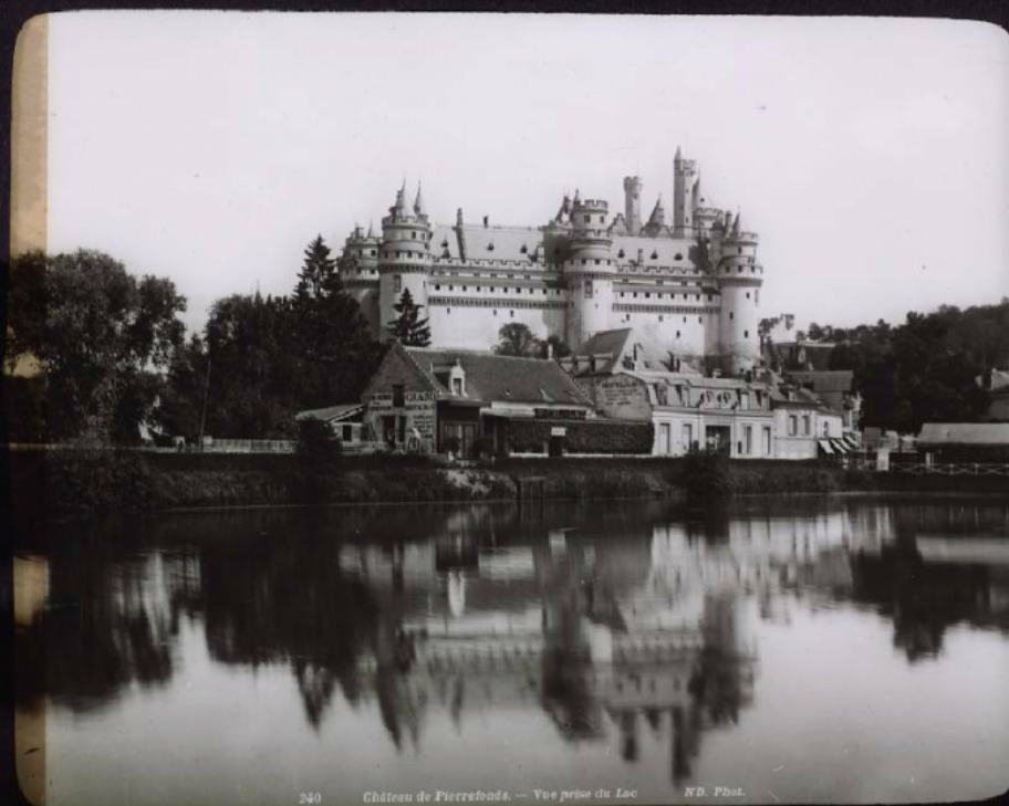
240 Château de Pierrefonds. — Vue prise du Lac N.D. Phot.
