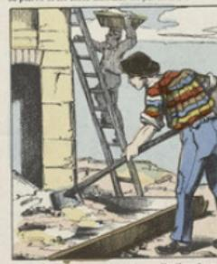
La chaux reçoit sa principale application dans la construction des murs. A cet effet, on la mélange avec de l'eau et de l'argile pour former une pâte suffisante et malaxer la pâte obtenue avec un racloir.
