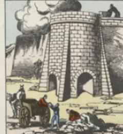
La chaux est obtenue par la calcination, c'est-à-dire par la chaleur, de diverses sortes de pierres à chaux. Ces pierres sont des carbonates de calcium qui, par la calcination, se décomposent en acide carbonique et en chaux. Les calcaires très purs donnent une chaux excellente dans leur composition; les autres donnent des chaux de qualités diverses.
