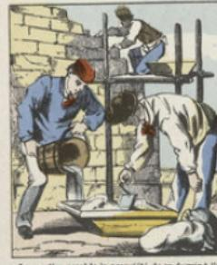
Le mortier possède la propriété de se durcir à l'air ou en contact avec l'air. C'est pourquoi il est nécessaire de préserver la chaux pour éviter que l'humidité ne la malaxe la pâte obtenue avec le mortier.
