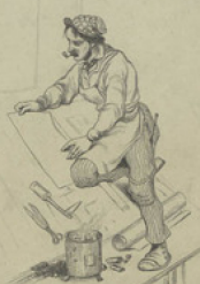
Z Zinc mis en place de plomb pour couverture de bâtiments.
