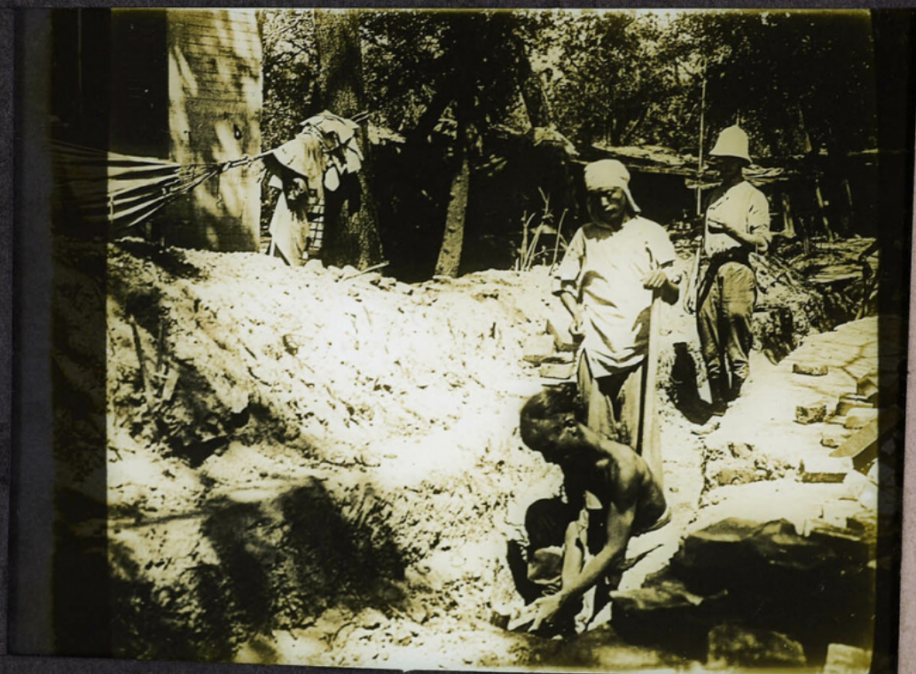
Les travaux de la tranchée aéri
