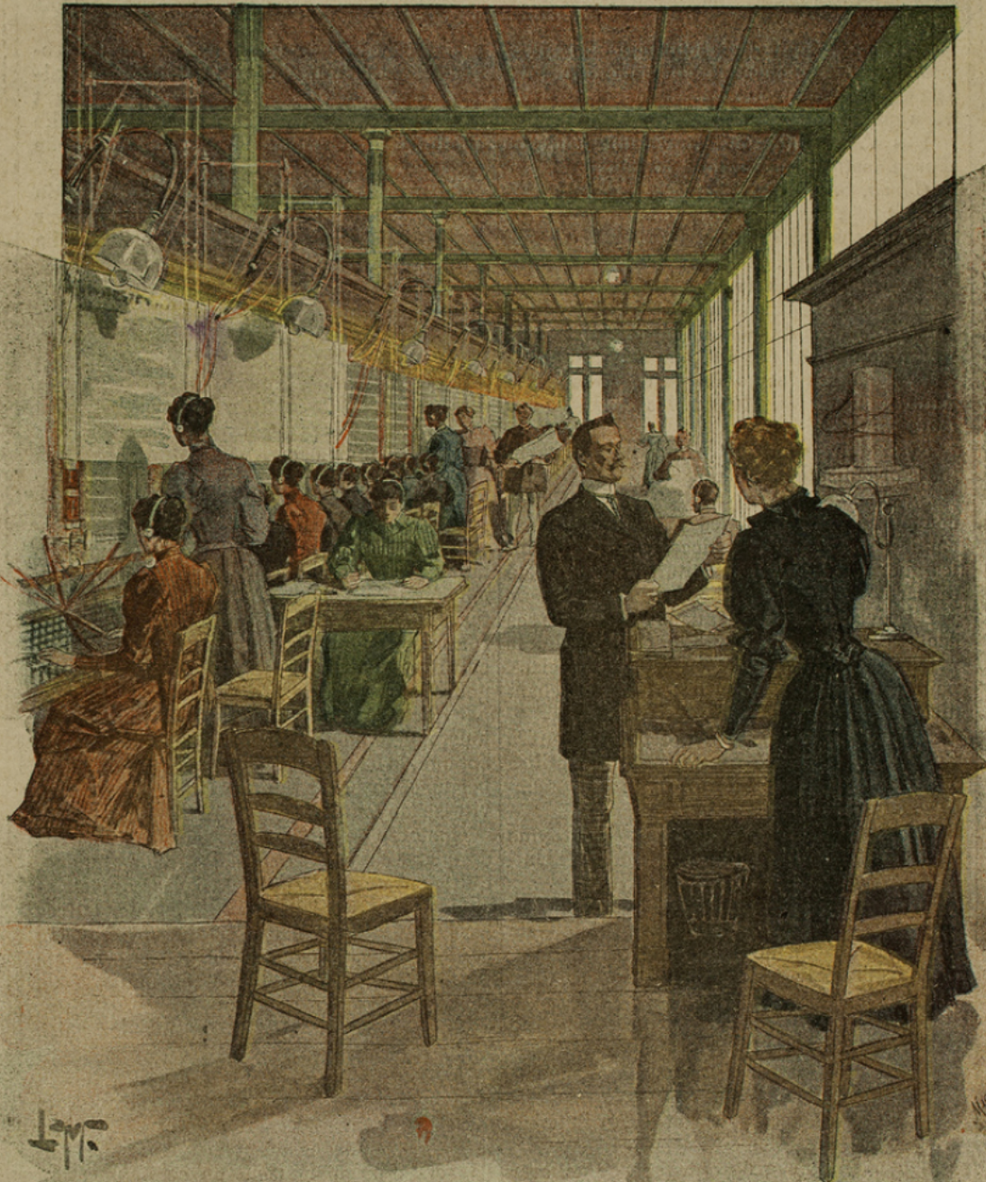
HOTEL DES TÉLÉPHONES SALLE DU GRAND COMMUTEUR
