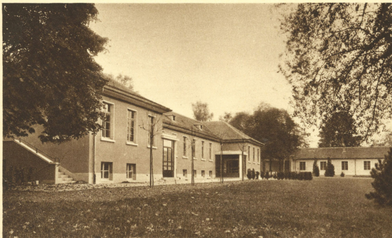
1. ÉCOLE DE PLEIN AIR — FAÇADE
