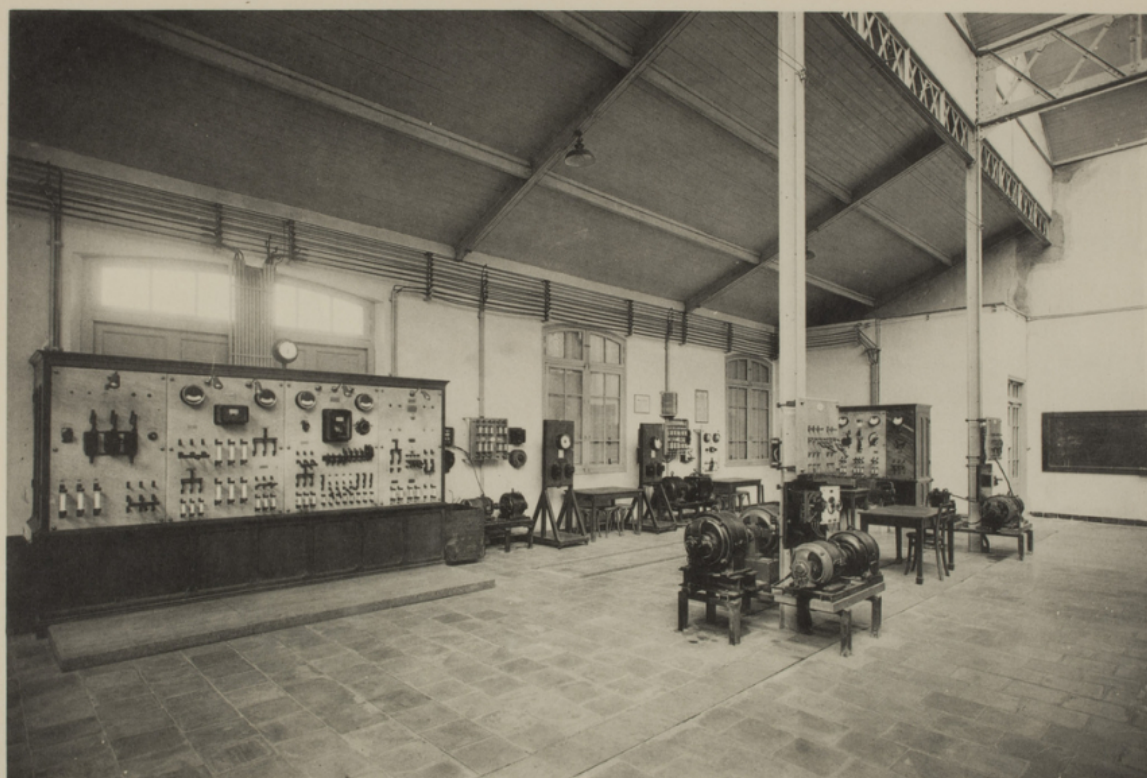
Un coin de l'Atelier d'Électricité (2)
