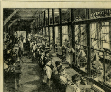
Fig. 6. — Ateliers de l'elanche, c'est-à-dire de la préparation des différentes pièces des montres, dans une fabrique moderne d'horlogerie.
