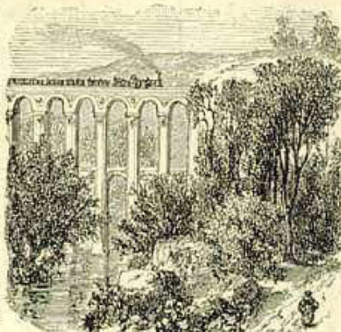
Chemin de fer passant sur un viaduc.
