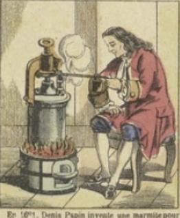
En 16<sup>th</sup> siècle, Denis Papin invente une marmite pour cuire la viande et les os au moyen de la vapeur concentrée en vase clos. Pour pouvoir suivre de l'œil la cuisson des viandes dans son Digesteur, il y fait un trou qu'il boucha avec une soupe. Telle est l'origine de l'application de la VAPEUR et de la soupe de vedette des chaudières.
