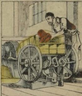
D'abord lavé à grande eau, la betterave est ensuite soumise au RAFAGE qui la réduit en pulpes. Les pulpes sont pressées entre des sacs de laine, et le jus qui sort des presses s'écoule dans des canaux où il est mélangé avec un fût de chaux.
