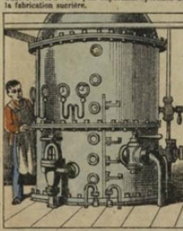
Le mélange est soumis à l'ébullition dans un appareil fermé dit APPAREIL À CLARIFIER et de là tombe dans des filtres en étoffe qui retiennent les impuretés en suspension, l'albumine coagulée et le noir animal.
