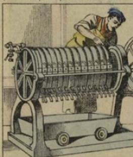
Le jus de betterave est conduit dans les chaudières à carbonatation et le précipité, contenant toutes les impuretés, sépare dans un FILTRE PRESSES. C'est la 1<sup>re</sup> et la plus importante opération de la fabrication sucrière.
