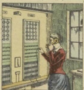
Dès 1876, des communications téléphoniques furent installées avec ce téléphone magnétique. Mais, pratique, sa portée se trouva restreinte à quelques kilomètres, à raison de la présence de courants anormaux sur les fils conducteurs.
