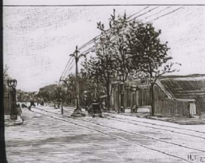
Vue d'un poteau supportant les fils.
