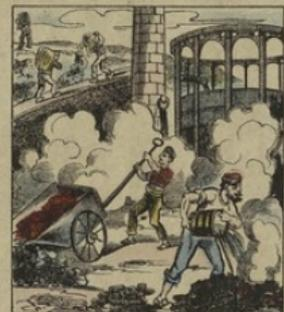
Le coke, retiré des cornues à gaz, est porté sur des wagonnets à un endroit de l'usine où on l'éteint sous des jets d'eau froide. Cassé ensuite en morceaux plus ou moins gros, il est vendu aux mineurs. La vente du coke paie à elle seule la fabrication du gaz.
