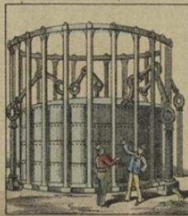
Le gaz, une fois purifié et propre à l'éclairage, se recueille dans une cloche creusée renversée sur de l'eau et qu'on nomme GAZOMÈTRE. Le gaz fait monter la cloche en s'y introduisant pendant la nuit. Le soir, quand on allume le gaz partout dans la ville, le gazomètre se vide et la cloche s'abaisse en poussant le gaz dans les tuyaux de conduite à travers les rues et les habitations.
