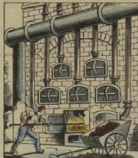
Le gaz est produit par la carbonisation de la houille qu'on charge dans des cornues de terre que l'on fait chauffer au rouge cerise. La houille distillée, le gaz s'échappe dans des tuyaux et dans les cornues reste le coke qui est un combustible précieux.
