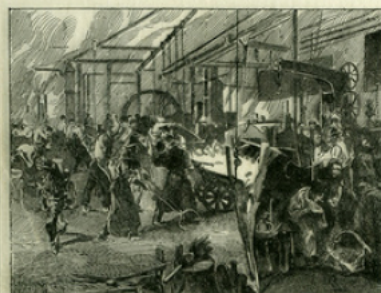
Fig. 10. — Usine Krupp à Essen : fonderie de l'acier.
