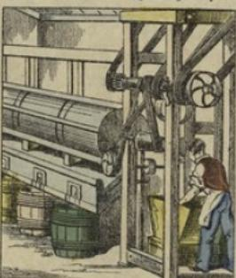
Torréfié, le cacao est transporté dans des machines à mortieriques, qui le conduisent dans un cylindre divisé où il se trouve avec une huile de graisse et son volume en 6 grosses cuvettes différentes, puis il est soumis à une ventilation qui chasse les cotons par derrière et laisse tomber l'amande en avant en éliminant les germes qui ne sont pas employés dans l'usine LOMBART. Le résultat de ces opérations est merveilleux.
