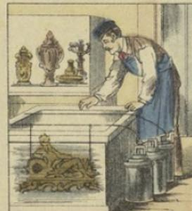
Les muscles, bien enduits de plombagine, sont alors descendus dans le bain et accrochés à des triangles métalliques reliés au pôle négatif de la pile. On fait passer le courant et quand on juge que l'épaisseur du dépôt est suffisante, on retire le moulé et on détache l'empreinte obtenue.
