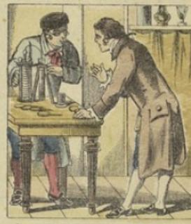
La première découverte due à la pile fut la décomposition de l'eau en ses deux éléments : hydrogène et oxygène, par le courant électrique. En 1800, Cartilis et Nicholson furent les premiers qui recueillirent de l'Hydrogène et de l'Oxygène en faisant passer le courant à travers une masse d'eau acide par de l'acide sulfurique.
