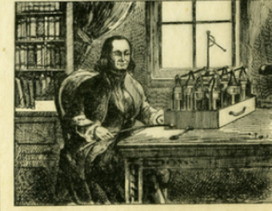
Fig. 6. — Première batterie électrique, inventée par Franklin (d'après une gravure du livre de Barbeu-Dubourg qui a traduit les œuvres de Franklin en 1773).
