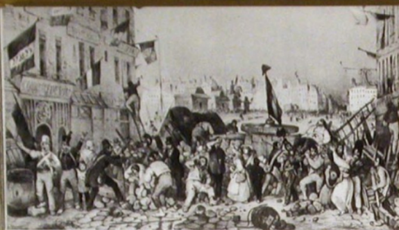
1. La Révolution de 1830 : la construction d'une barricade.
