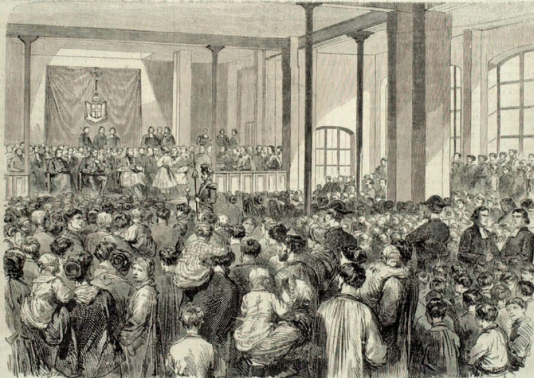
PARIS. — Inauguration, dans le préau couvert, des écoles du boulevard des Amandiers.
