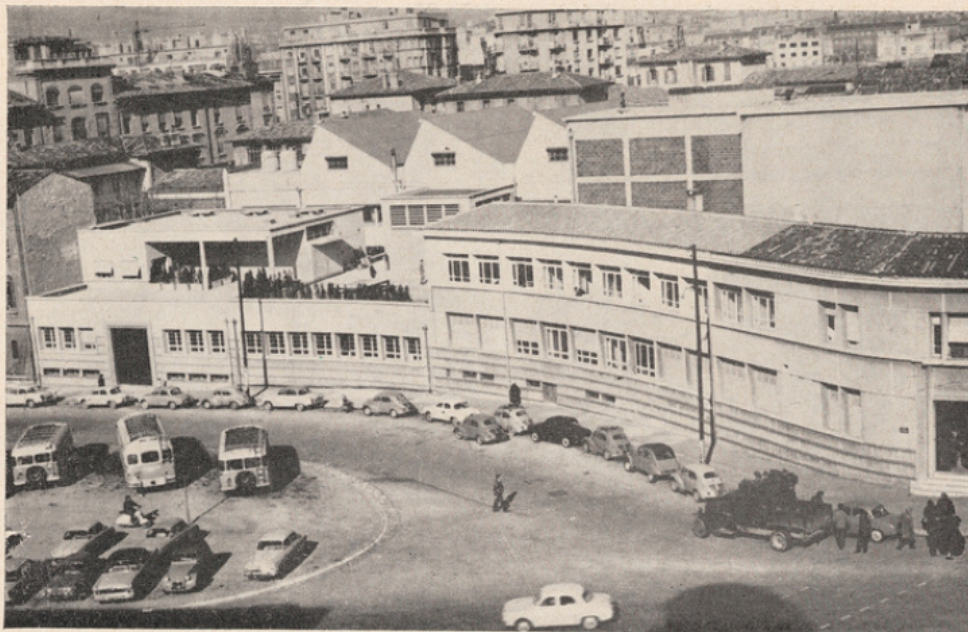
L'Institut de mécanique des fluides de Marseille.
