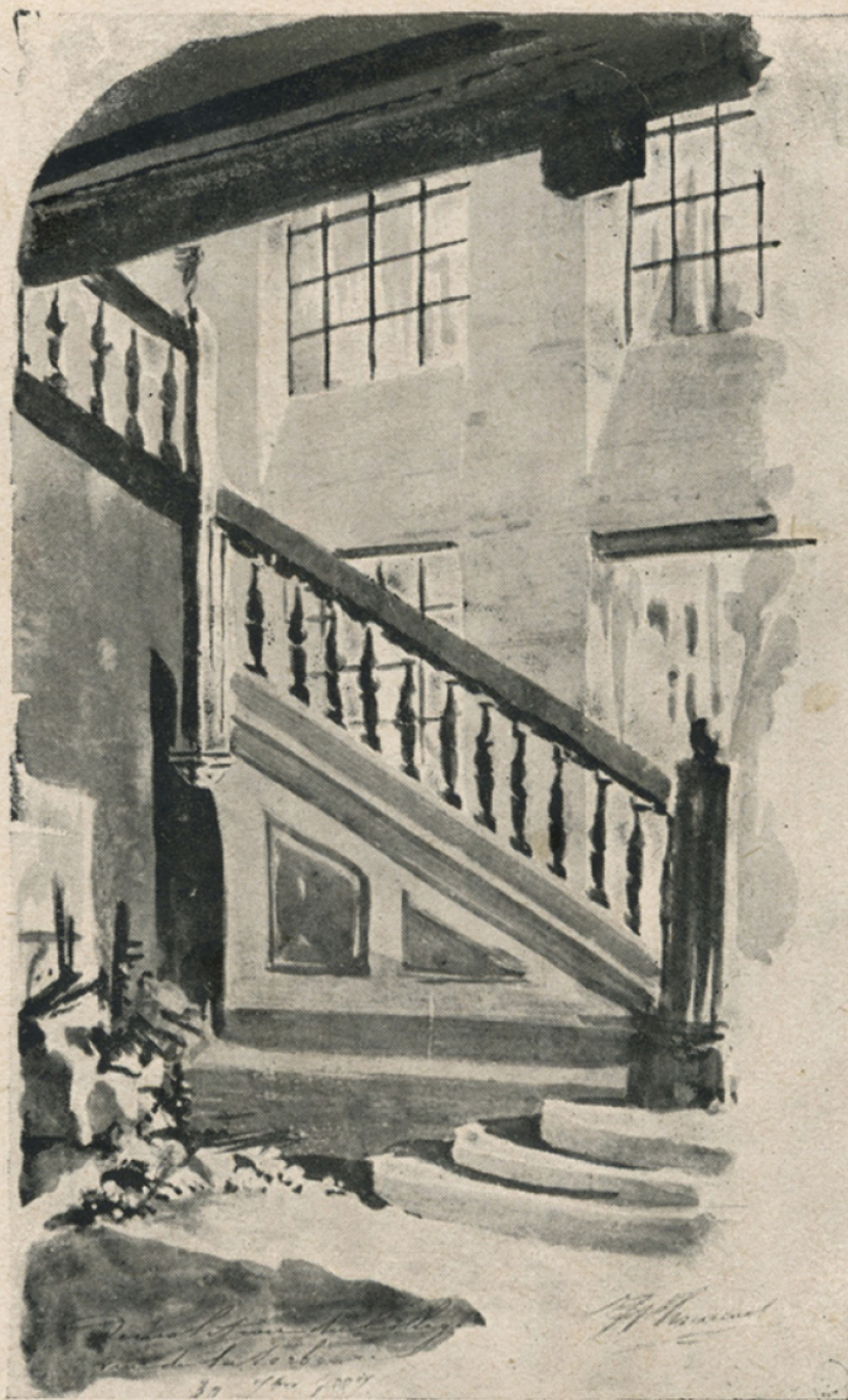
Fig. 26. — Escalier du Lycée, vu de la Sorbonne, pendant la démolition, en septembre 1887. (Dessin relevé de sépia.)
