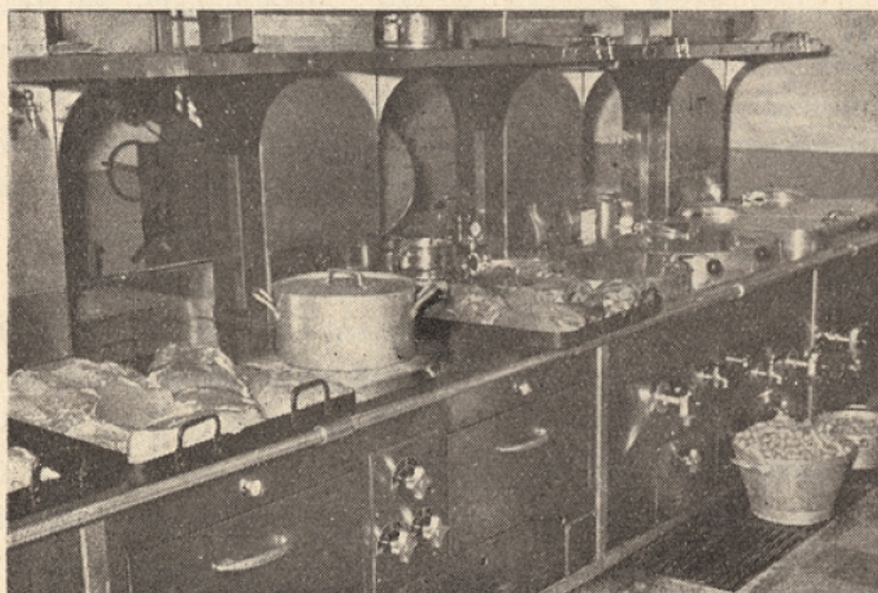
Installation récente de la cuisine
