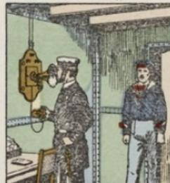
**Téléphone haut-parleur.** En employant un microphone spécial, il est devenu possible de donner au téléphone une puissance supérieure à celle de la voix humaine. Nous signalerons le système Gaillard-Ducroquet employé sur les navires de guerre pour remplacer les tuyaux acoustiques et les porte-voix.
