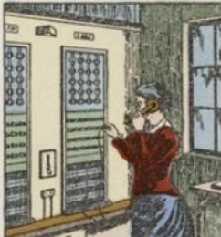
Dès 1876, des communications téléphoniques furent installées avec ce téléphone magnétique. Mais, en pratique, sa portée se trouva restreinte à quelques kilomètres, à raison de la présence de courants anormaux sur les fils conducteurs.
