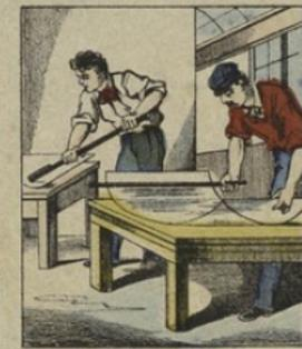
Le manchon une fois fendu, peut s'ouvrir et se développer sur une plaque d'argile qu'on remet au four pour le réchauffer. Avec une longue perche de bois, on rabat les deux côtés et on les aplatisse de façon à obtenir une surface aussi dressée que possible.
