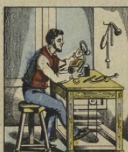
En chauffant du verre à la flamme d'une lampe d'émailleur, on peut le tourner et le contourner à l'infini, en lui donnant les formes les plus capricieuses. C'est ainsi qu'on FILE le verre pour fabriquer ces bijoux, petits navires, animaux, maisonnettes etc. qu'on voit dans les foires.
