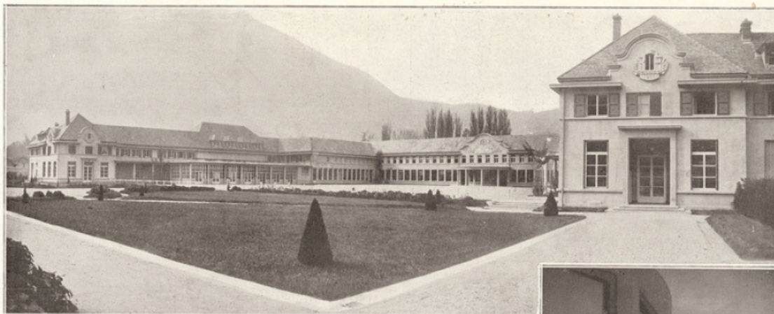
Le développement « linéaire » des bâtiments de l'école professionnelle de Vizille, près de Grenoble. MM. Robert Fournet et Louis Sainsaulieu, architectes.
