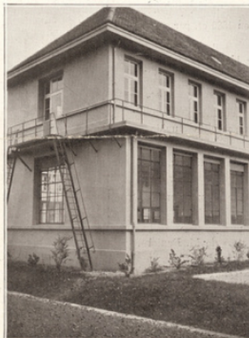
Les balcons en ciment armé et les échelles de fer pouvant servir de dégagement en cas d'incendie. Tous les bâtiments possèdent ce dispositif de sécurité.
