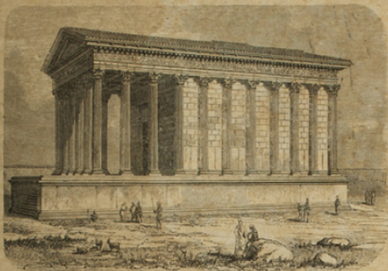
La Maison-Carrée, à Nîmes.
