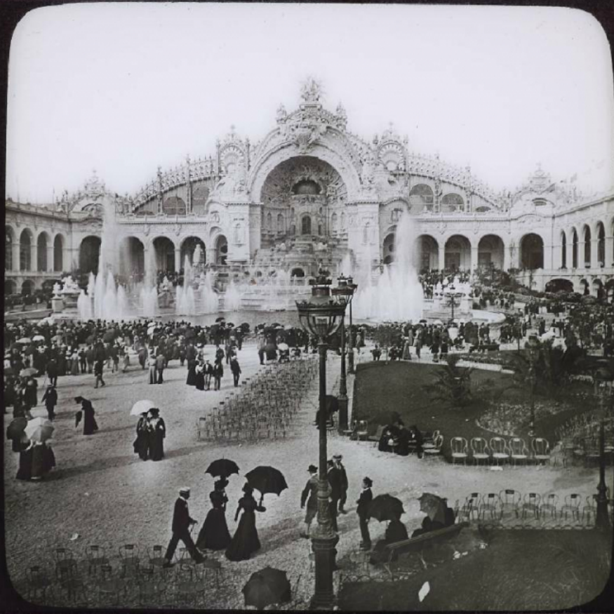
Vue générale du château d'eau Exps. 1900
