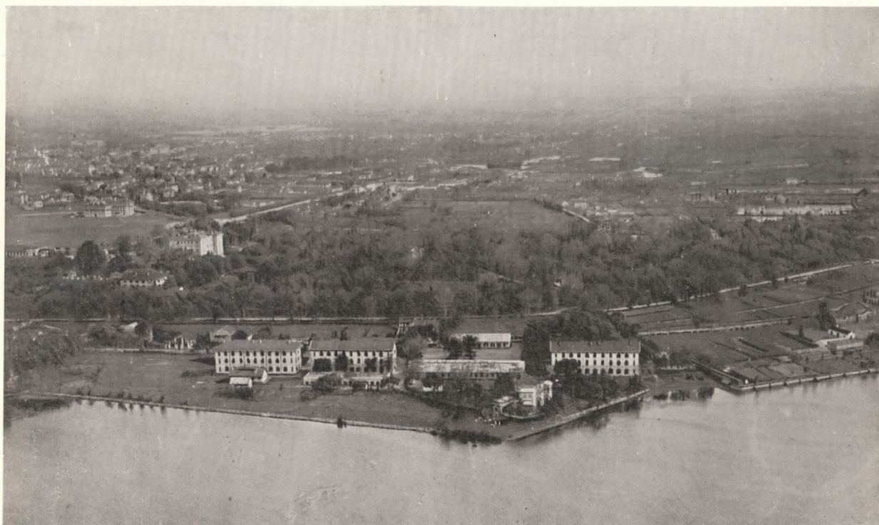
HANOI, LYCÉE DU PROTECTORAT. — VUE AÉRIENNE (LE LYCÉE SE TROUVE ENTRE LE GRAND LAC ET LE JARDIN BOTANIQUE).
