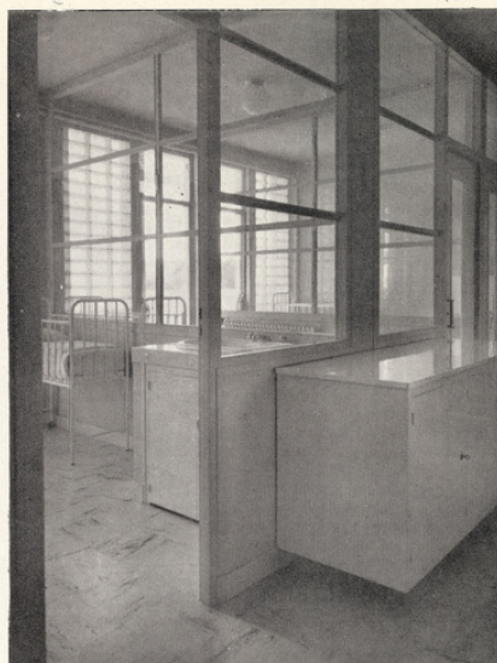
Les dortoirs sont séparés les uns des autres par des cloisons vitrées en partie haute de façon à faciliter la surveillance de l'ensemble. Toute la partie vitrée extérieure est traitée en briques translucides de Saint-Gobain. Le sol est en dalles plastiques Dalflex. Les enfants sont baignés, pesés et changés dans les dortoirs pour éviter les risques de refroidissement par déplacements dans les couloirs. Ci-dessous, on remarquera aussi le système de cloisons mi-hautes isolant chaque lit.
