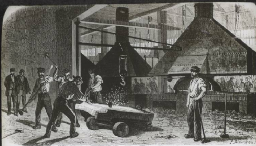
LES GRANDS ÉTABLISSEMENTS DE LA MARINE IMPÉRIALE. — URSIN D'INDRET. — La chaudière: l'épave d'une plaque à tubes.
