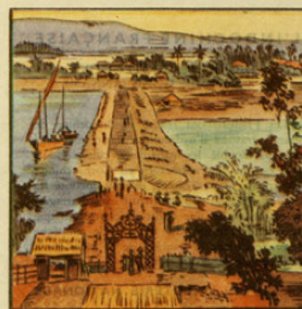
DIGUE DE PROTECTION A CHAN-MÉ GONG/ANNAM
