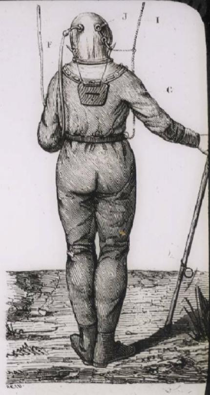
Plongeur revêtu de l'appareil Cabriol, vu de dos.
