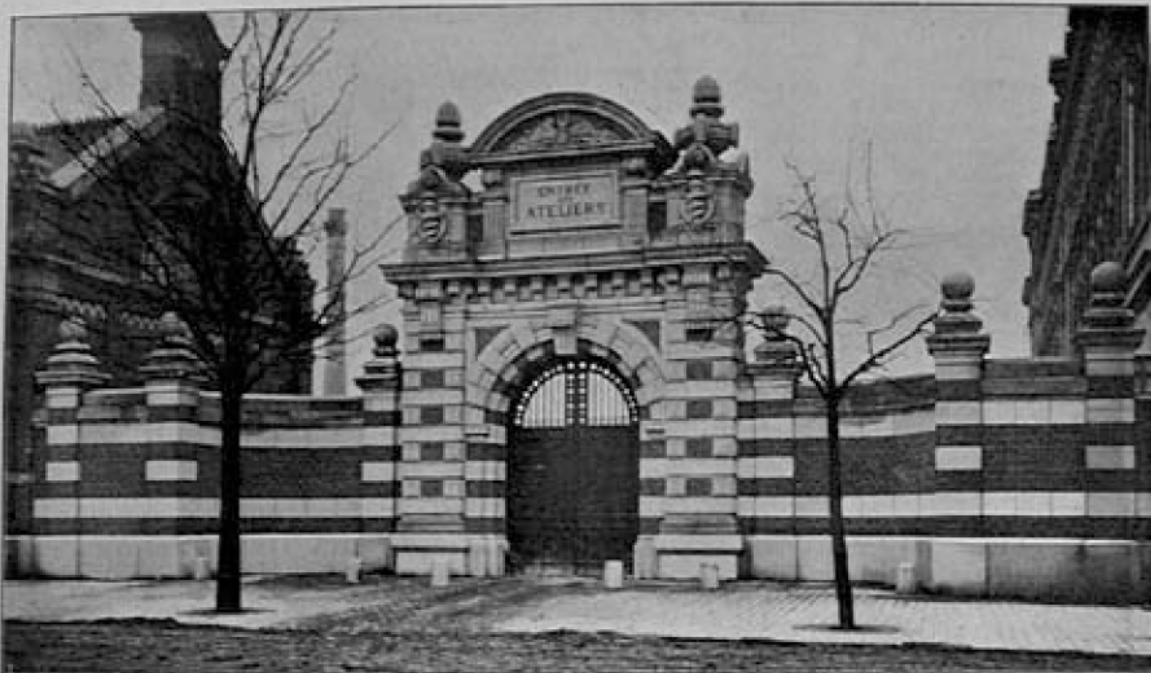
L'entrée des ateliers de l'École.
