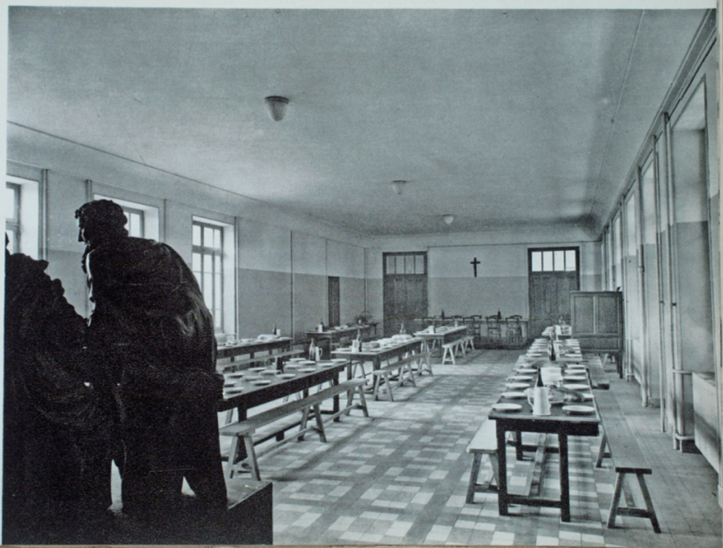
Le Réfectoire vu de l'entrée : avec un détail de la Cène (14)
