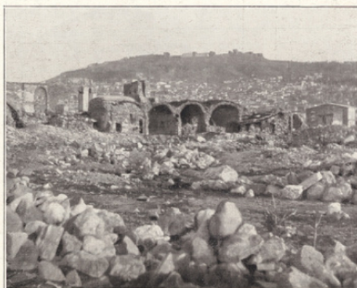
Au pied du Pagus : arcades à demi brisées dont certaines, obstruées, servent d'habitations.
