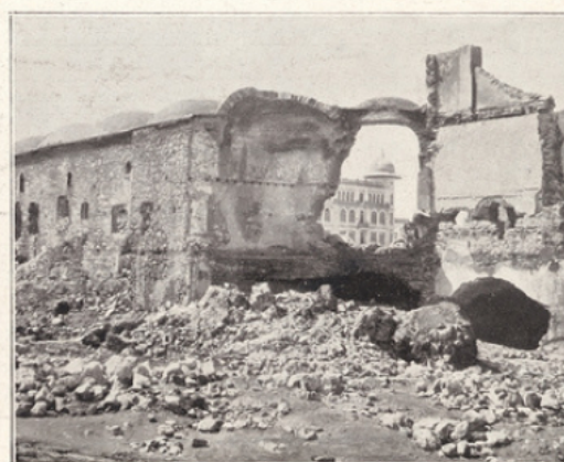
Silhouette d'un bâtiment neuf vue par une brèche dans les murs d'un ancien hammam.
