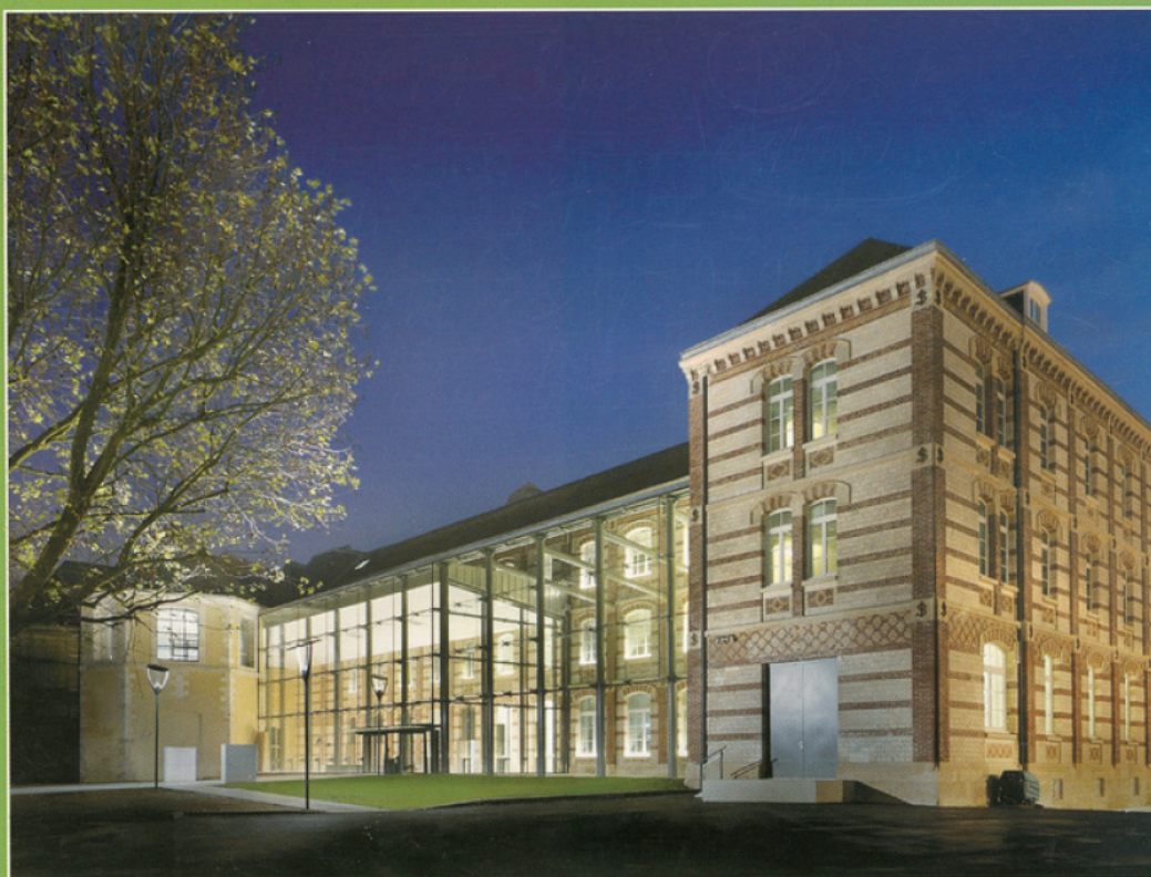
Entrée du Pôle des Savoirs, 115 boulevard de l'Europe à Rouen, ex E.N.G.
