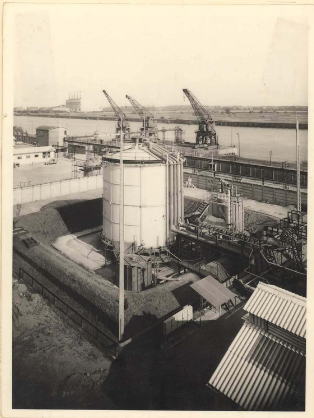
Station d'essais de liquéfaction du méthane à NANTES Deux solutions sont envisagées pour le transport du méthane. D'une part une canalisation sous-marine; d'autre part des bateaux méthaniers qui seront des sortes de pétroliers transportant du méthane liquéfié à pression normale et à une température de -160^{\circ} , ce qui présente différents problèmes qui sont étudiés à la station de NANTES. On distingue au fond la centrale électrique de NANTES-CHAVIRE qui est alimentée en gaz naturel
