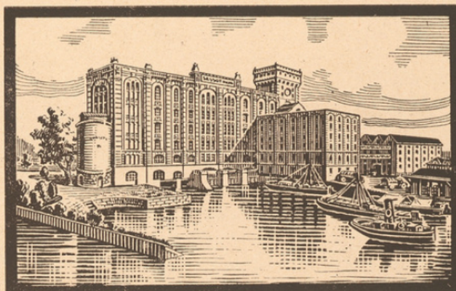
Grands Moulins de Nogent Construits entièrement en briques de laitiers
