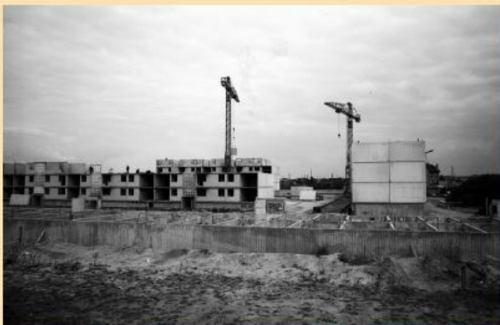
Construction des immeubles de la cité Marcelin-Berthelot
