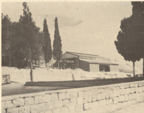
Atelier de soudure - Welding shop
