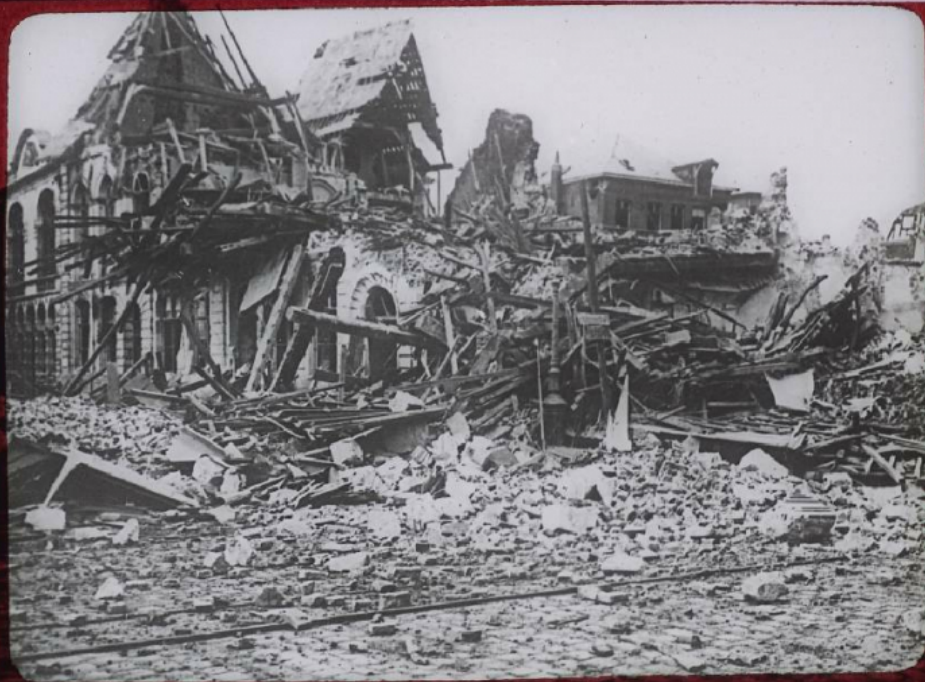
C 01992 Nord (Armentières) . . n° 20 Ruines d'une maison mune par les allemands
