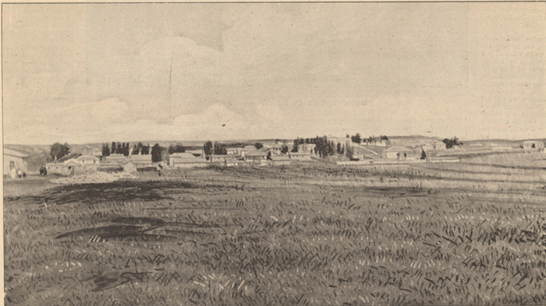
Vue générale de l'Institut agricole de Mikweh, près Jaffa
