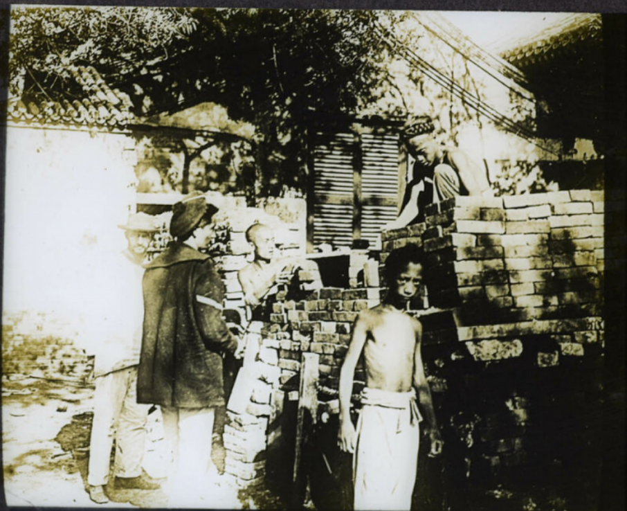
13 Construction d'une palissade
